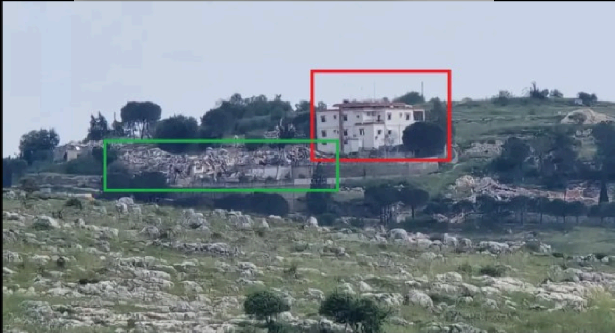
Photo montrant le bâtiment abritant un dispensaire géré par l'Ordre de Malte visiblement intact, en rouge ; en vert, l'édifice du couvent des Sœurs du Saint-Sauveur est réduit à un tas de ruines. © Diocèse grec catholique de Tyr.
